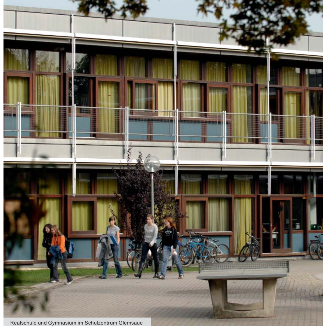
Realschule und Gymnasium im Schulzentrum Glemsaue
