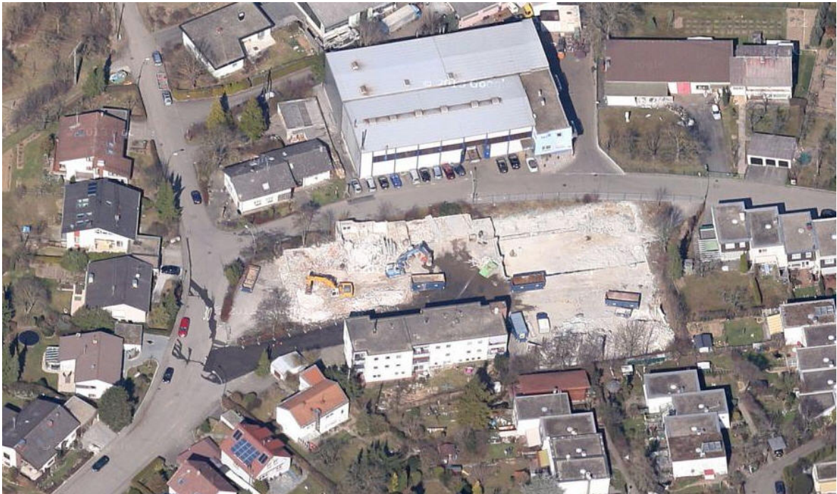
Abb. 2: Schrägluftbildaufnahme des Plangebietes
